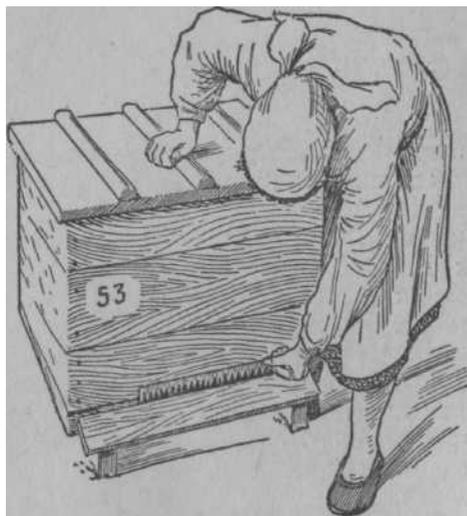
Р и с. 116. Леток улья, закрытый железной пластинкой с пилообразными отверстиями для предохранения от доступа мышей.
